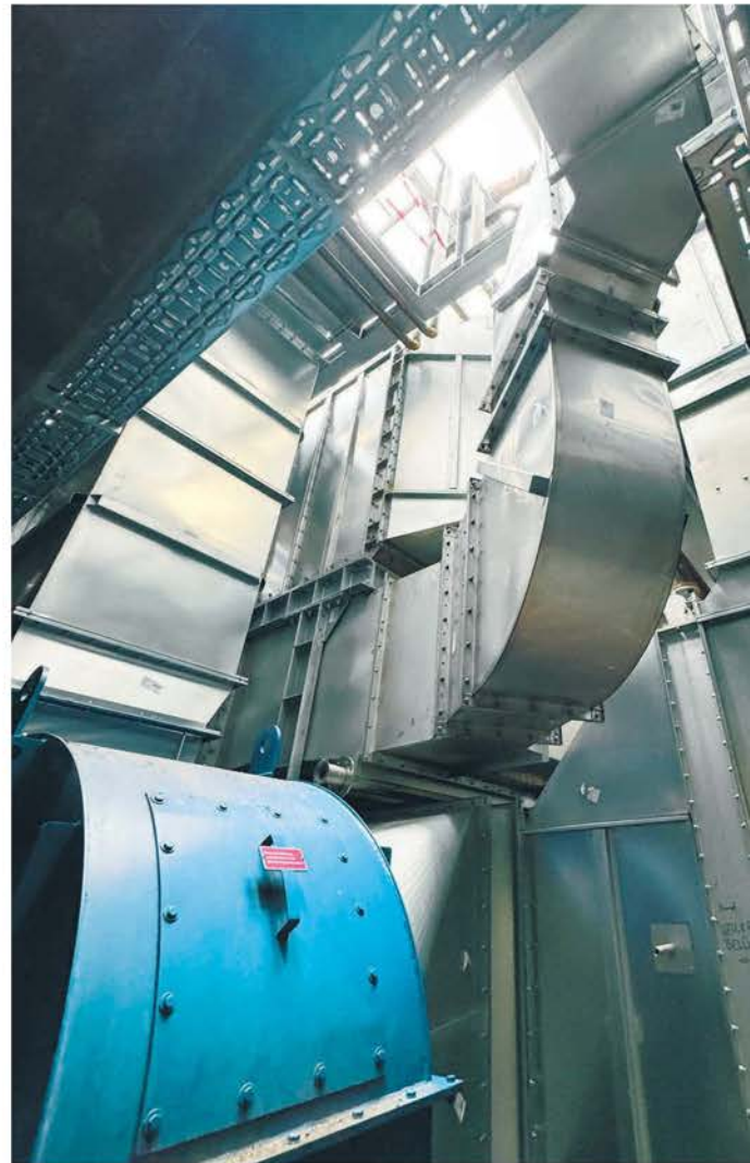
rechts: Zu- & Abluftkanäle Neue Wärmerückgewinnung
