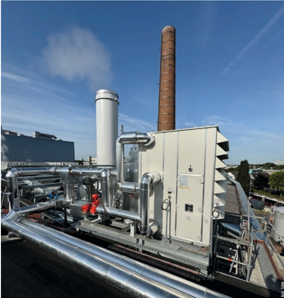
Wärmerückgewinnungsturm 1 & 2
